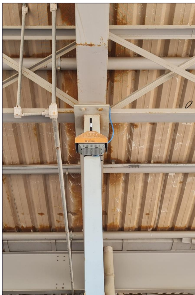
Figura 3 - Localização estação de monitoramento da qualidade do ar
